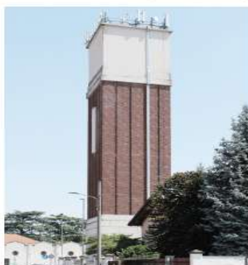
Fig. 0.5 Serbatoio a "torre littoria"
