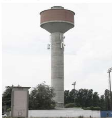
Fig. 0.4 Serbatoio "a fungo" con vasca cilindrica
