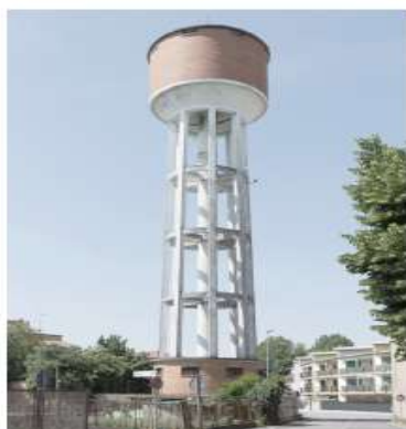
Fig. 0.2 Serbatoio tipo "Hintze"
